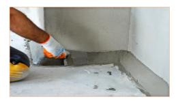
Устойчивый к сульфатам и хлору, тиксотропный, цементный, армированный полимерами и фиброй ремонтный конструкционный раствор.
